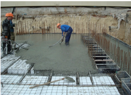
Рис. 2. Процес бетонування плити архітектурно-будівельної системи «Монофант»
