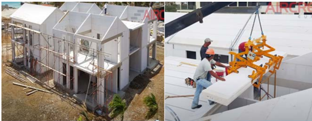
Рис. 2. Будівництво будинків з використанням газобетонних панелей
