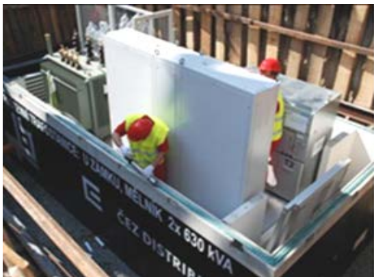
Рис. 5. Фрагмент монтажу підземної трансформаторної підстанції
