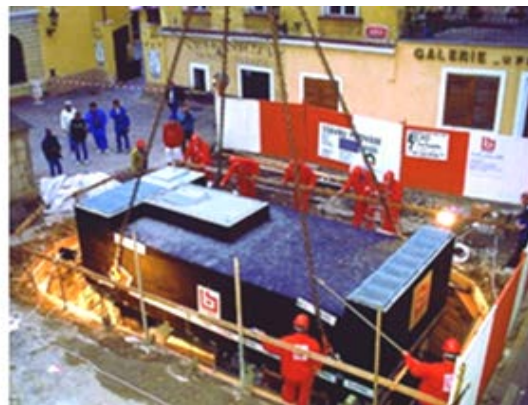
Рис. 5. Фрагмент монтажу підземної трансформаторної підстанції
