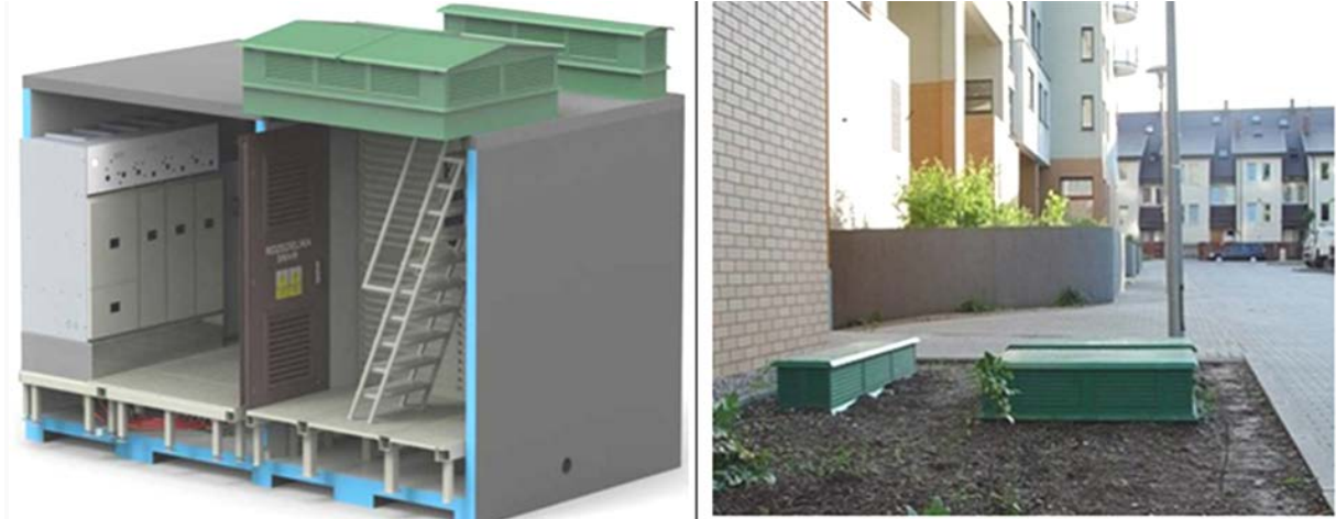
Рис. 6. Фрагмент польських підземних підстанцій ZPUE
