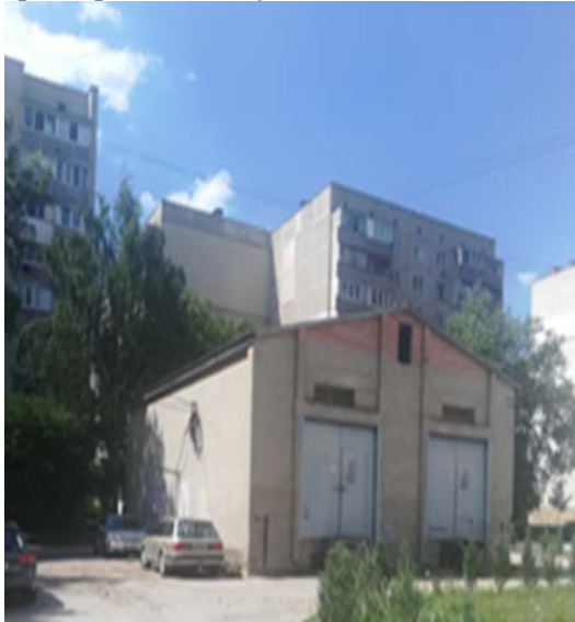
Рис. 3. Зовнішній вигляд трансформаторної станції, м. Вінниця
