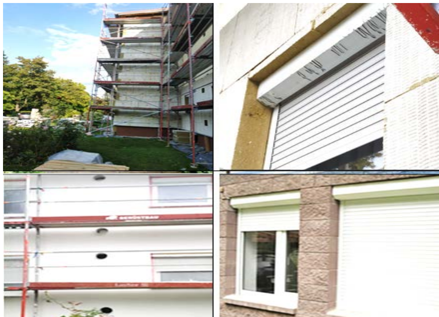
Рис. 7. Фрагмент комплексного утеплення стін з одночасною заміною вікон та влаштуванням ролет (німецький досвід, м. Хайльброн, 2023 рік)
