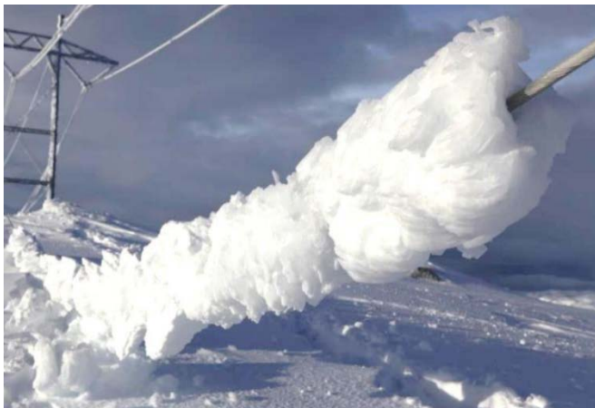
Рис. 1. Руйнування проводу ЛЕП внаслідок налипання снігу та утворення ожеледі
